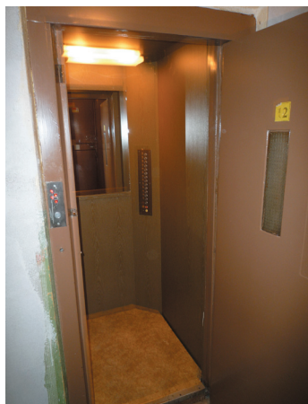
Bratislava, Baltská, malý výťah
